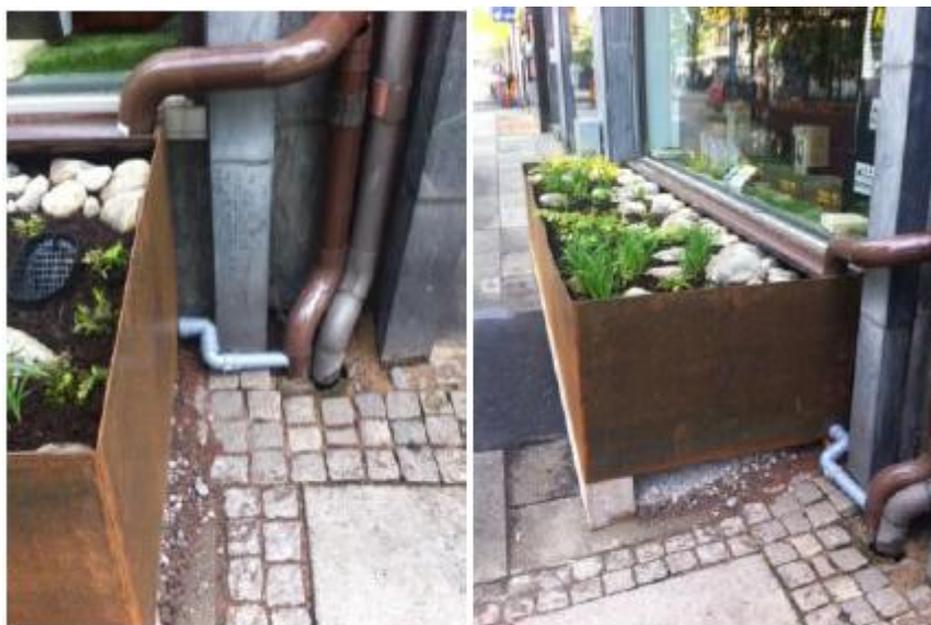
Figur 12. Regnträdgård i upphöjd behållare, här anslutet direkt till stuprör (Kretslopp och vatten, 2016)
