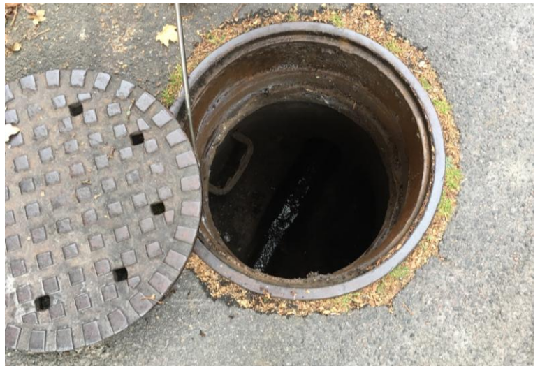
Figur 7. (nedan) Rensbrunn vid Gårda 33:48. Ledning för kombinerat dag- och spillvattennät. Avrinning söder- och österifrån.
